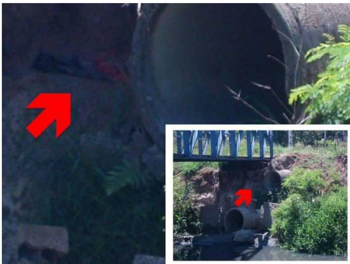
Foto 1 - Detalhe da aparente exposição da estrutura.
